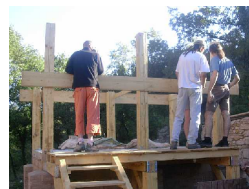
Montage de la charpente bois de nos toilettes à compost
