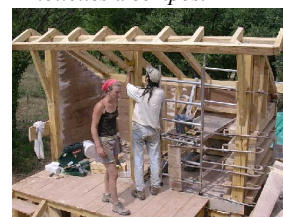
Montage de la charpente bois de nos toilettes à compost
