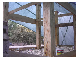
Montage de l'ossature bois
